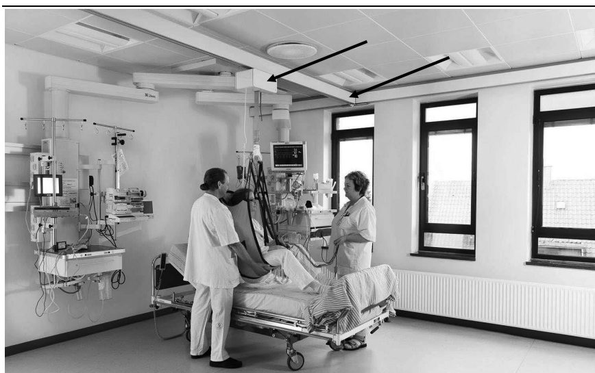
Figura 3 - Esempio di sollevamalai a soffitto. Le due frecce indicano gli elementi strutturali: trave e sollevatore mobile
